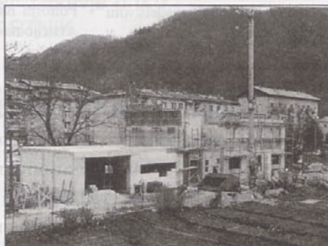
Gradnja nove pošte v Zagorju
