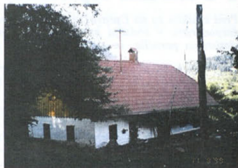
Sanacija starejšega in dotrajanega ostrešja
