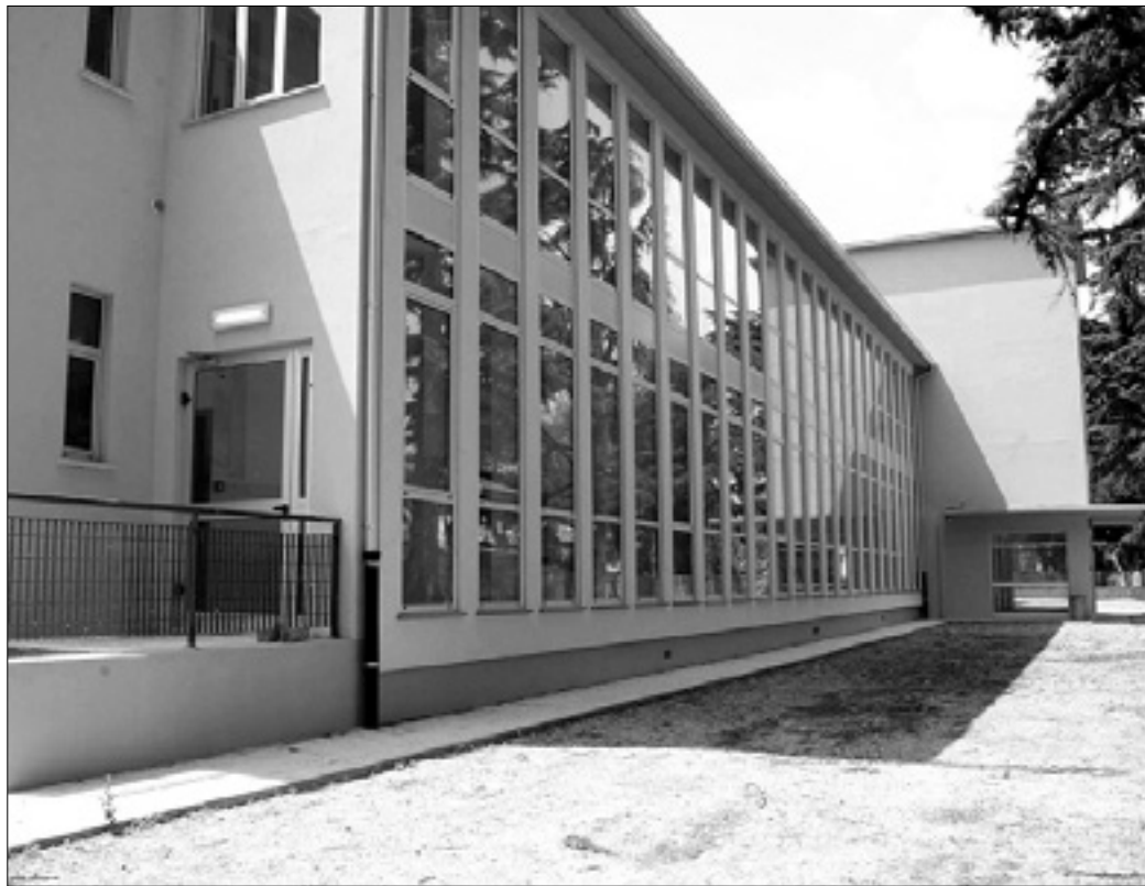
Obnovljeno šolsko poslopje v ulici Capitello v Romjanu, ki čaka na vrnitev osnovnošolcev.
