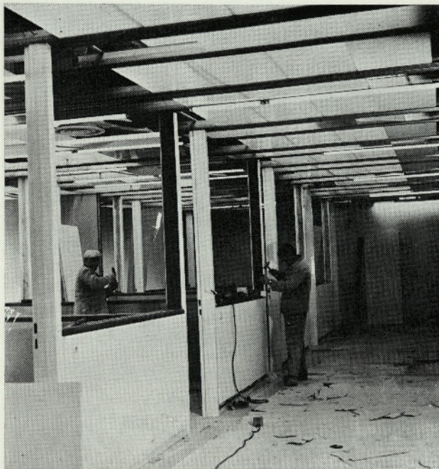
Izvajanje zaključnih del v DTS objektih
