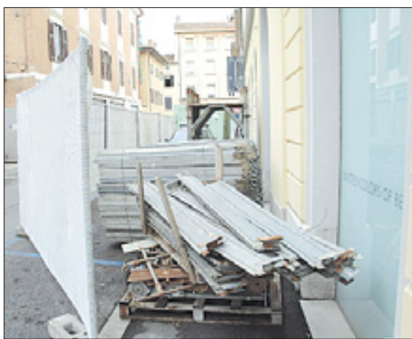
Gradbišče med Korzom in Ulico Contavalle
