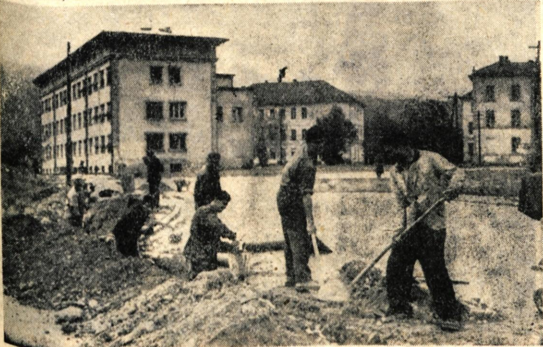
V Radovljici v teh dneh polagajo podzemni kabel za javno razsvetljavo
