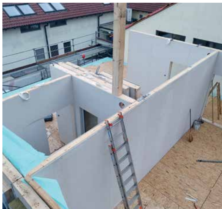
Sestavljanje montažne konstrukcije prizidka
