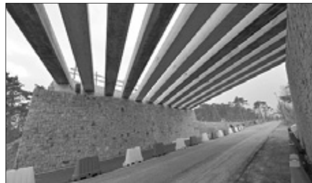
Pogled izpod mosta na nameščene tramove
