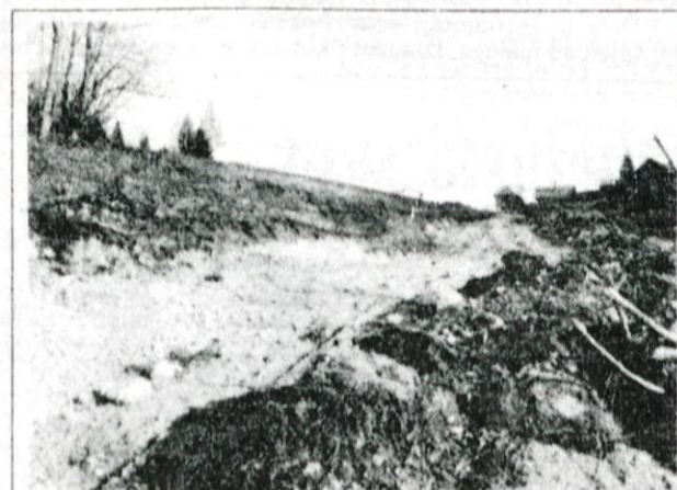
Gradnja ceste med Koprivnikom in Zgornjim Podjelijem
