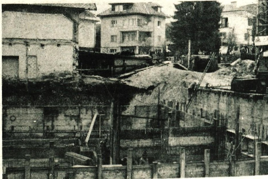
Bled — Lani se je nekaj hotelov odločilo za obnovo svojih objektov in za gradnjo prizidkov. Poleg hotela Lovca so že začeli z gradnjo novega trakta, v katerem bo 64 postelj. Tako bodo imeli v Lovcu po obnovi skupaj 153 postelj, novo restavracijo s 140 sedeži in družabni prostor. Hotel Lovca bo tako obdržal kategorijo B, z deli pa naj bi končali maja letos. (D. S.) — Foto: F. Perdan
