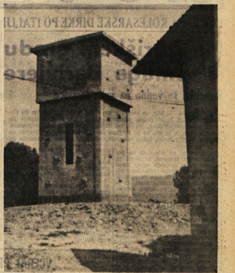
Vodovodni rezervoar v Steverjanu, od koder se steka voda, ki prihaja z Oslavja, odteka k potrošnikom v zgornjem delu vasi okoli cerkve
