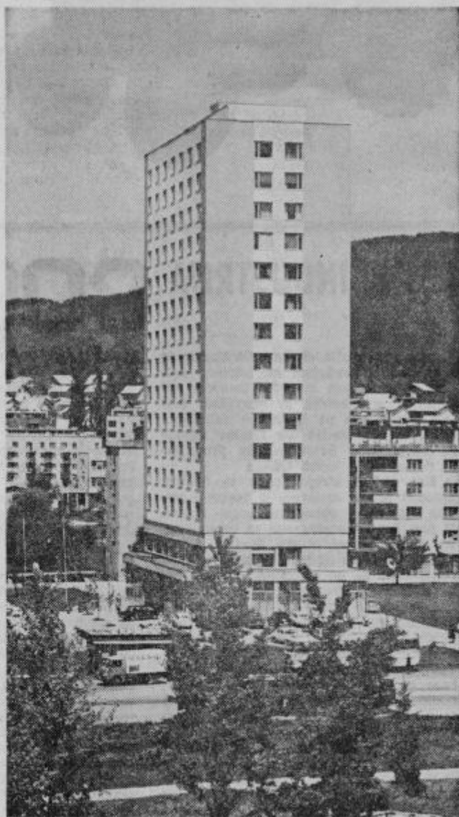
Tudi za ometom te velenjske stolpnice in drugih hiš se skrivajo elektrofilterski zidaki.
