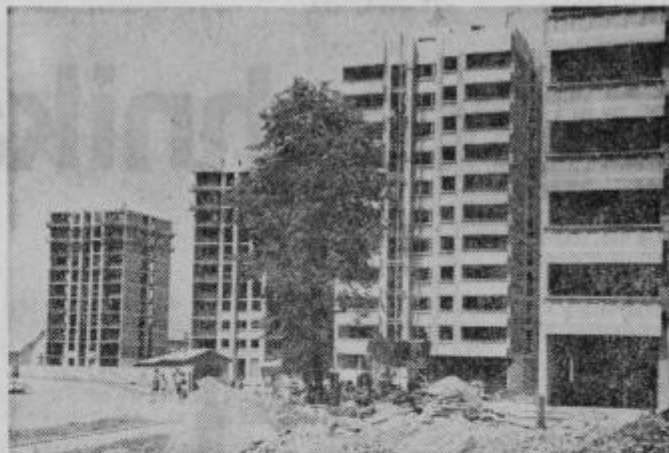
Štiri nove stolpnice v Velenju, štiri nove stanovanjske zgradbe in nešteto elektrofilterskih zidakov...
