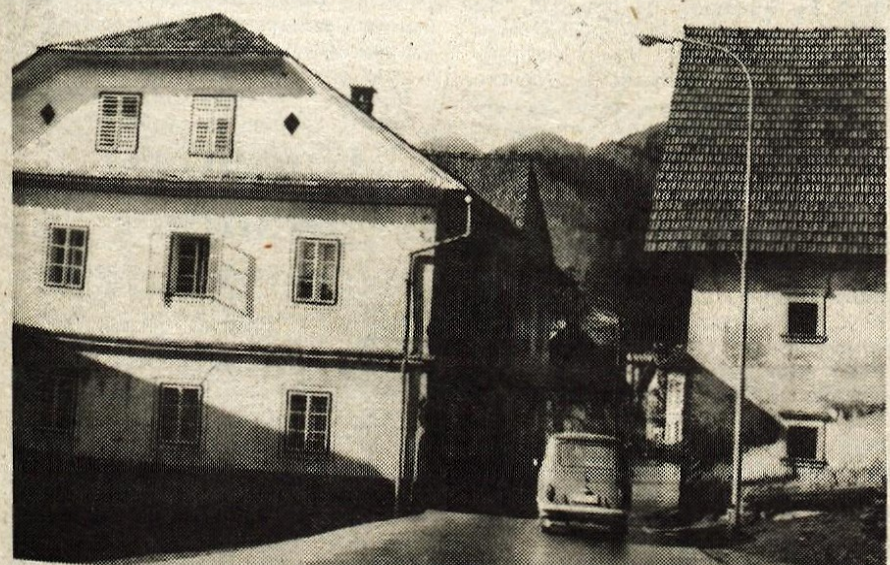
ŽELEZNIKI — Referendum v krajevni skupnosti Železniki je uspel. Udeležba na vseh šestih voliščih je bila zares dobra. Prebivalci s tega področja so se pač zavedali, da je njihove »prometne žile« potrebno na vsak način urediti. To pa bo mogoče seveda le s skupnimi močmi. Že v bližnji prihodnosti bo tako odpravljeno tudi tole ozko »grlo« med Češnjico in Ze-lezniki. (—jg) — Foto: F. Perdan
