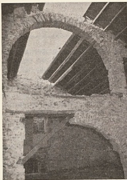
Pred sanacijo druge etaže in podstrešja
