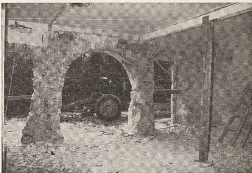
Sanacijska dela v pritličju
