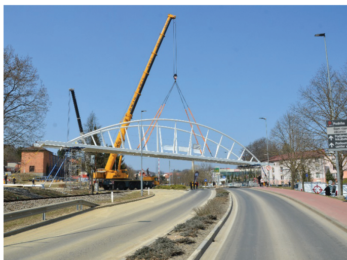
Slike 11 do 15. Montaža jeklene konstrukcije s pomočjo dveh avtodvigal, marec–april 2022 (Foto: Ponting, d. o. o.).
