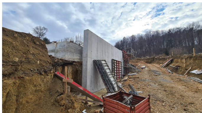
Sliki 9 in 10. Izvedba podpornih ukrepov v sklopu P&R-parkirišča v neposredni bližini, februar 2022 (Foto: Ponting, d. o. o.).
