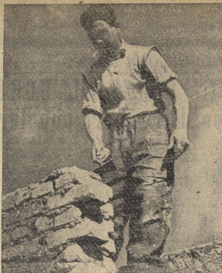
Un muratore italiano al lavoro
