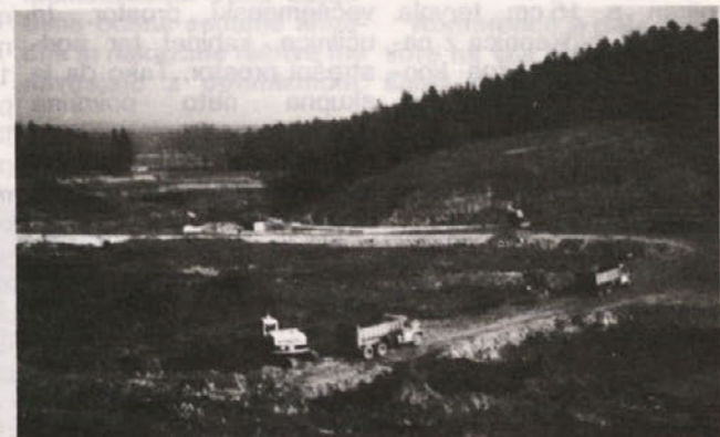
Gradnja nove deponije Cinkarne Celje. Zemeljska pregrada bo imela višino 45 m, dolžino 687,50 m ter širino 6 m na vrhnem delu pregrade. Zgrajena bo iz gline, meljaste gline, peščenjakov in piritnih ogorkov. Dela izvajamo v izredno težkih pogojih. D. Čmak.
