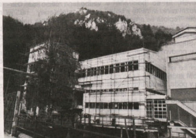
Dela na Vodarni se končujejo. Gradi TOZD GO Laško.
