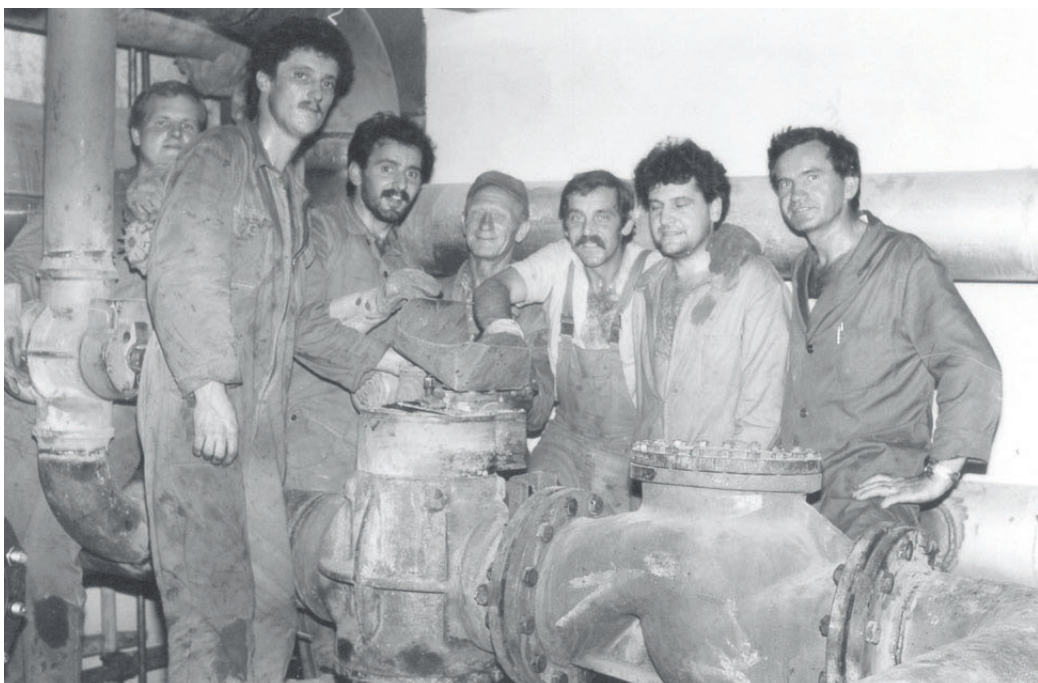
Remont sistema daljinskega ogrevanja nekoč
