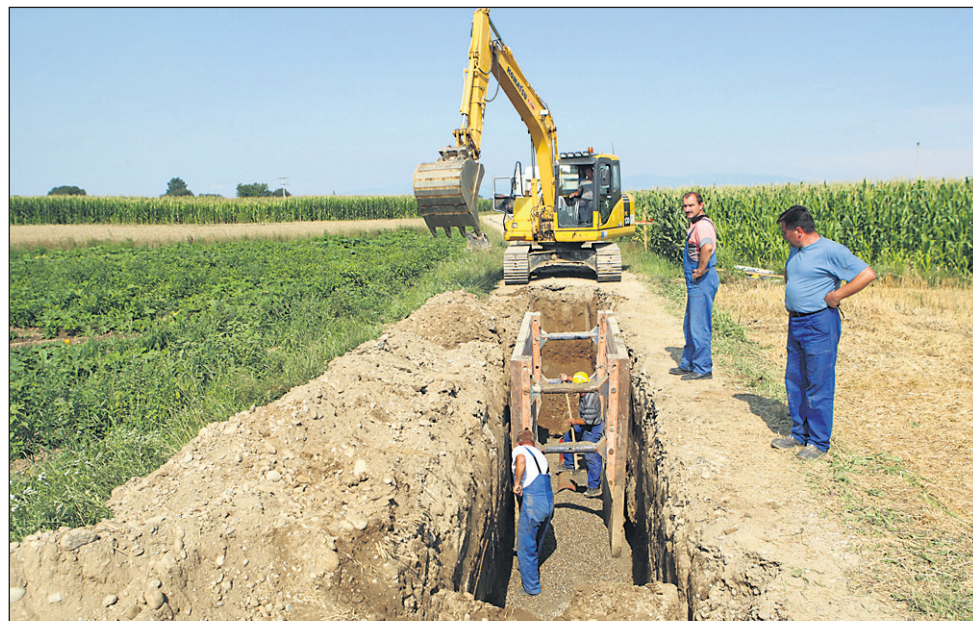
Gradnja prve faze projekta podtalnice bo zaključena v letu 2010.
