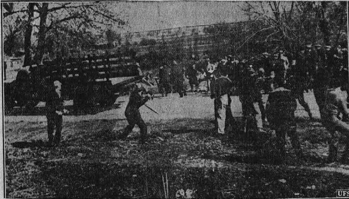
Delavci, ki so se priglasili na delo pri gradnji mostu čez reko Missouri pri St. Charles, Mo., so bili sprejeti od piketov, ki ne puste, da bi kdo delal pri gradnji tega mostu, kdor ni v uniji.
