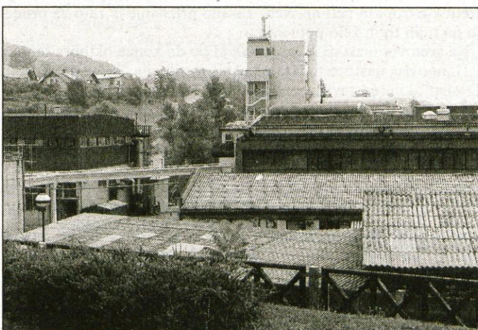
V zadnjih letih so veliko vlagali, investicija v tehnološko ekološko sanacijo je znašala sedem milijonov mark. Izrednega pomena je naprava za regeneracijo topil (bela stavba v središču), ki jih izloča iz odpadnih voda in zraka ter pri tem dosega skoraj 90-odstotno učinkovitost. Letošnje naložbe so manjše, znašajo 1,4 milijona mark. Poskrbeli bodo za klimatizacijo prostorov, kar bo dodatno izboljšalo delovne razmere.
