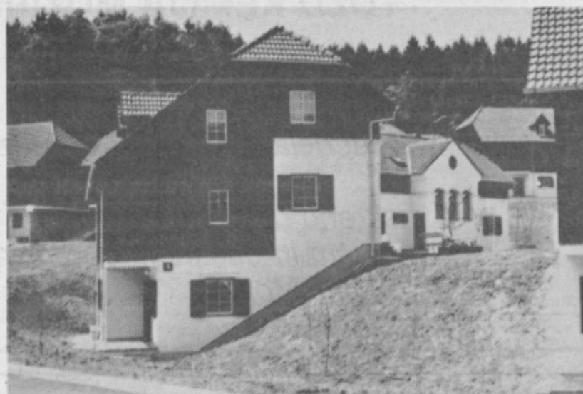
Na sliki je nekaj objektov iz Atomske vasi, ki jih gradi Ingradov tozd Gradbeništvo Rogaška Slatina. Objekte so pohvalili tudi že tuji turisti.
