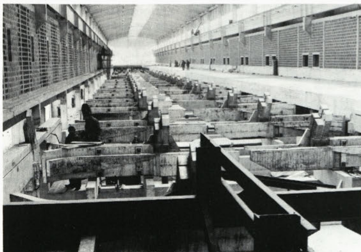
Dvorana elektrolize C
