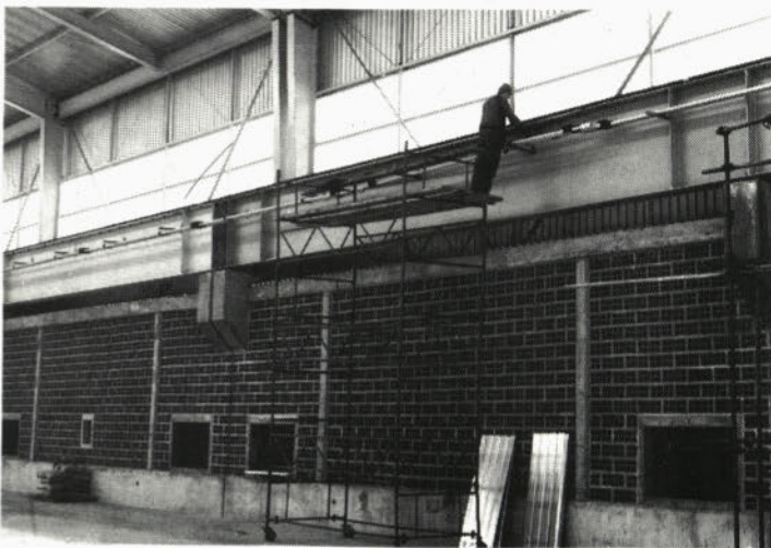
Montaža žerjavne proge, 18. 3. 1987
