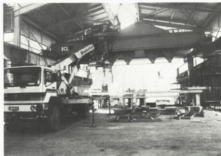
Zaključna montaža žerjava
