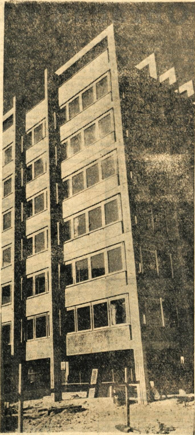
Takle nebotičnik je že dni rasel na Trati pri Škofji Loki. V njem bo tamkajšnja »Predilnica« uredila poslovne prostore
