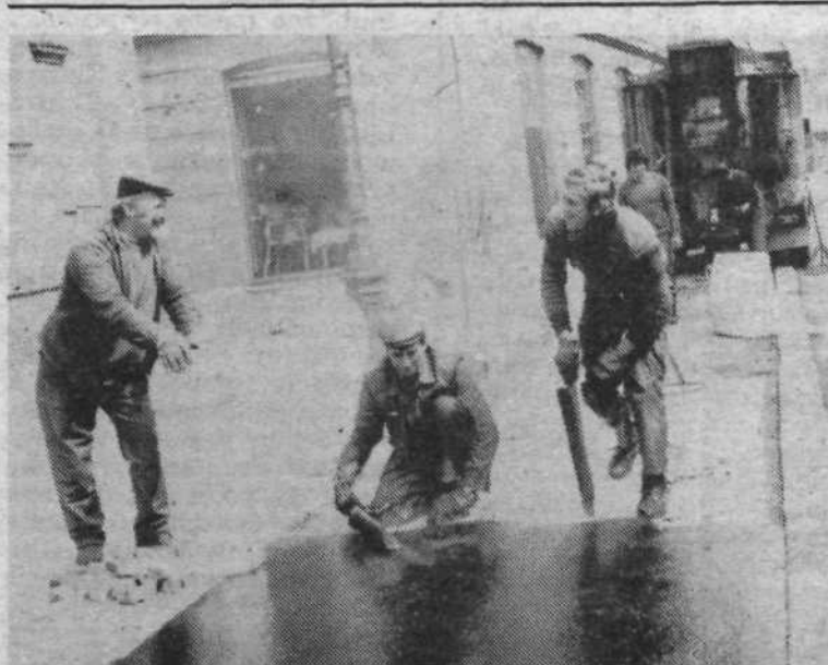
Delavci Komunalnega podjetja Ljubljana TOZD komunalne gradnje redno obnavljajo pločnike in ulice po naši občini. Nedavno so prelili z asfaltno maso tudi pločnik na Ciril-Metodovem trgu v neposredni bližini spomenika, ki opozarja na demonstracije ljubljancank 1943. leta. (Foto: S. J.)
