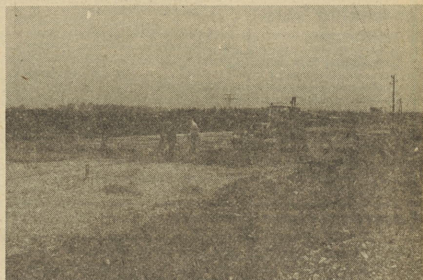
Gradnja priključka Stegenske ceste.
