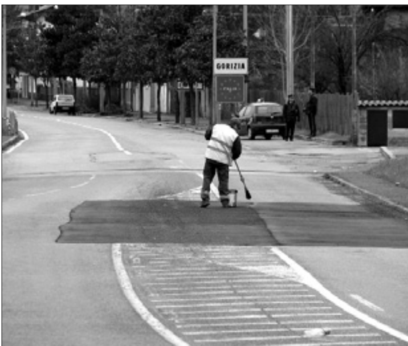
Delavci Komunale so te dni zaključili z asfaltiranjem
