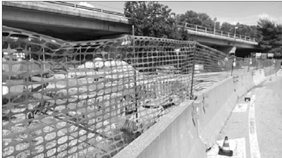
Gradbišče pod viaduktom onemogoča vožnjo z Majnic proti Podgori
