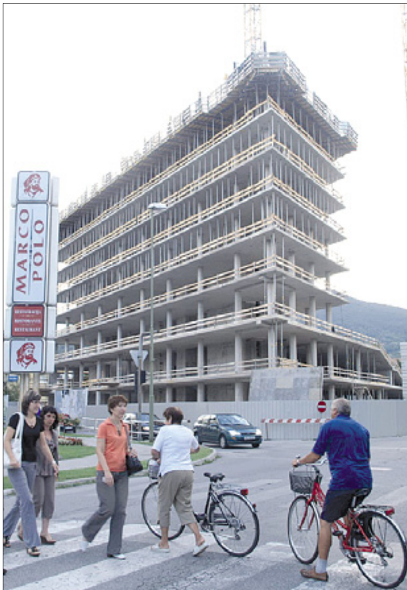
Gradbišče Eda centra v Novi Gorici
