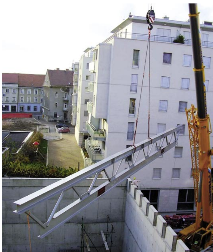
Slika 9 • Montaža jeklenih paličnih nosilcev strehe telovadnice
