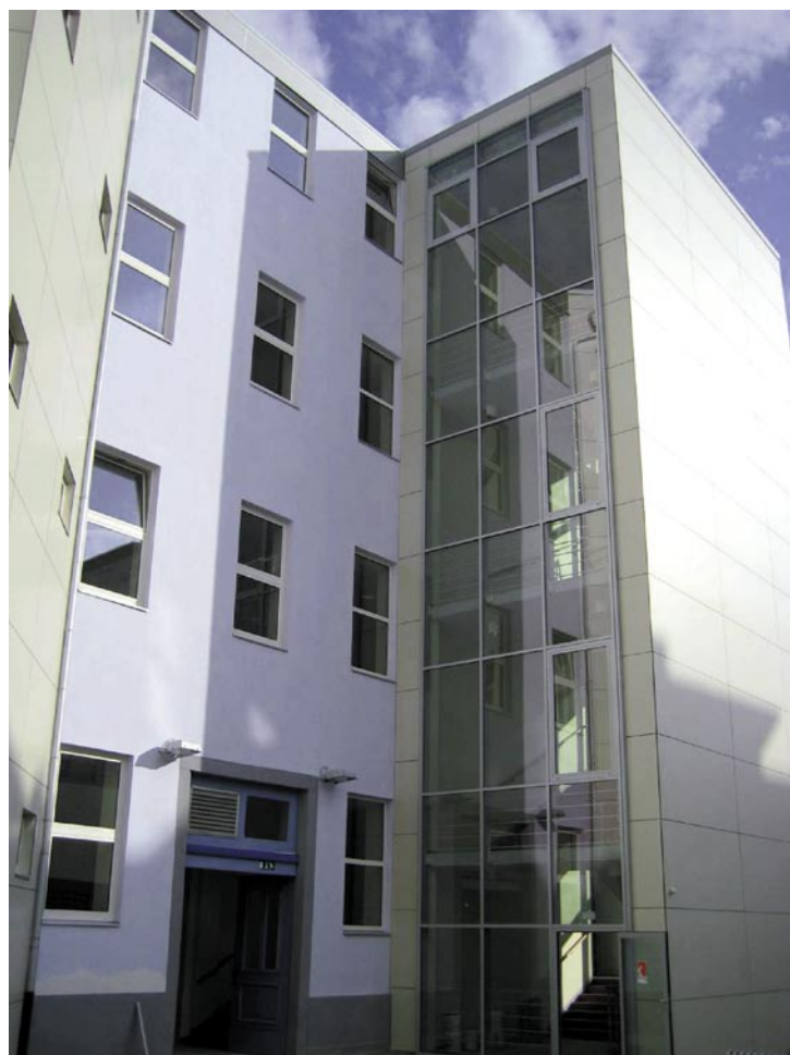
Slika 13 • Novo betonsko stopnišče
