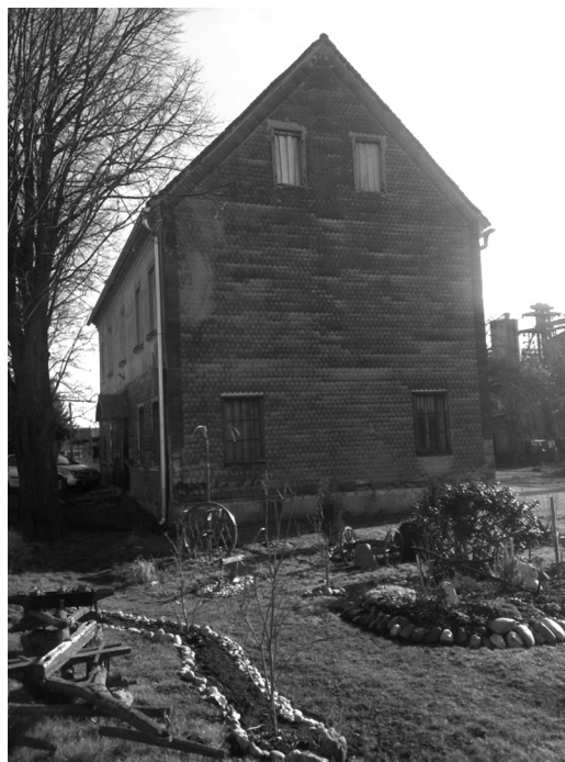
Zgradba nekdanjega vrtca v Črncih danes
