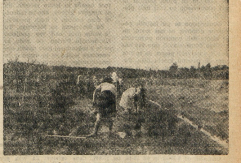
MLADINA VOJVODINSKIH KOLONISTOV PRI GRADITVI ŽELEZNISKE PROGE SEZANA-DUTOVLJE
