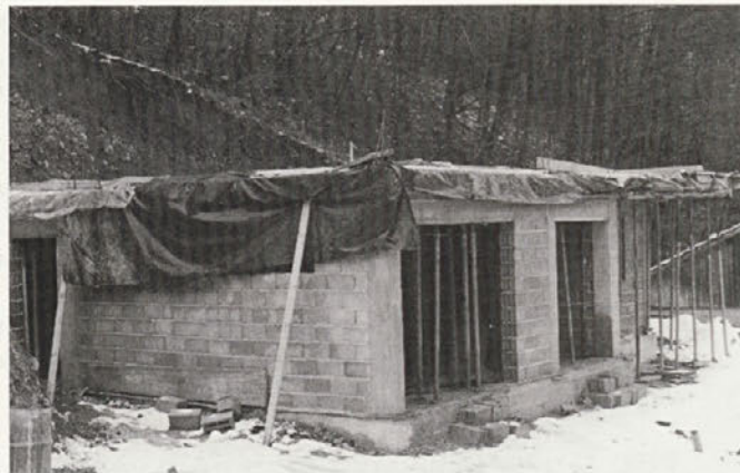
Prva plošča je zabetonirana.
