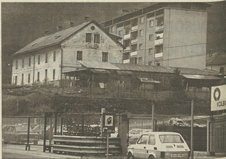
Stanovalcem s Tomšičeve 19 bodo morali zagotoviti nadomestna stanovanja (Foto: R. B.)
