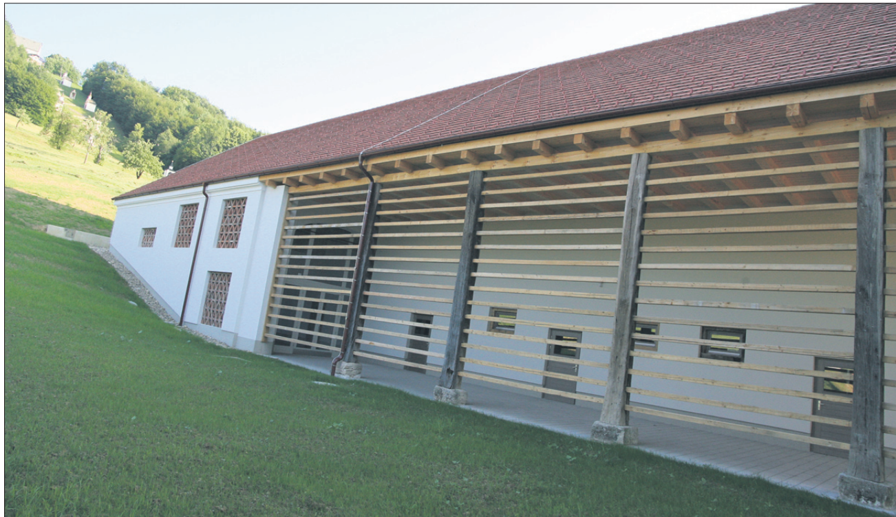
Župnijski gospodarski objekt so popolnoma obnovili in ga tudi razširili. Muzej je zasnovan tako, da je iz njega čudovit pogled na kalvarijo svetega Roka (na levi). Pritličje starega dela stavbe je še vedno v lasti šmarske župnije, lastnica muzejskega dela je občina.
