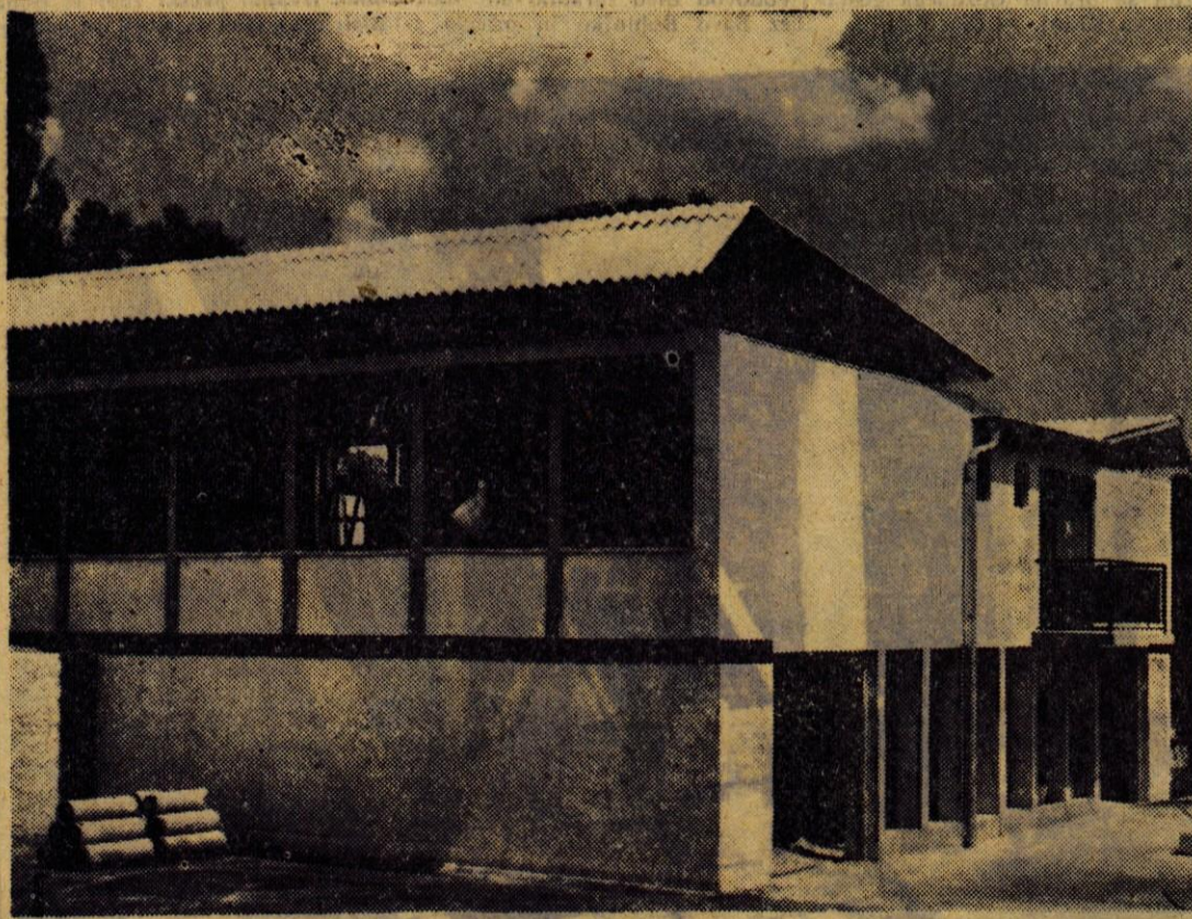
Poslopje rajonske delavnice kranjskega »Vodovoda« v Škofji Loki, v Plevnem, je dograjeno. Gradnja je skupno z opremo veljala okrog 11 milijonov, z obratovanjem pa bodo začeli, kakor pravijo, že septembra
