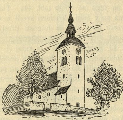
Sl. 45. Sv. Jernej. Pogled na župnijsko cerkev od severozapada.
