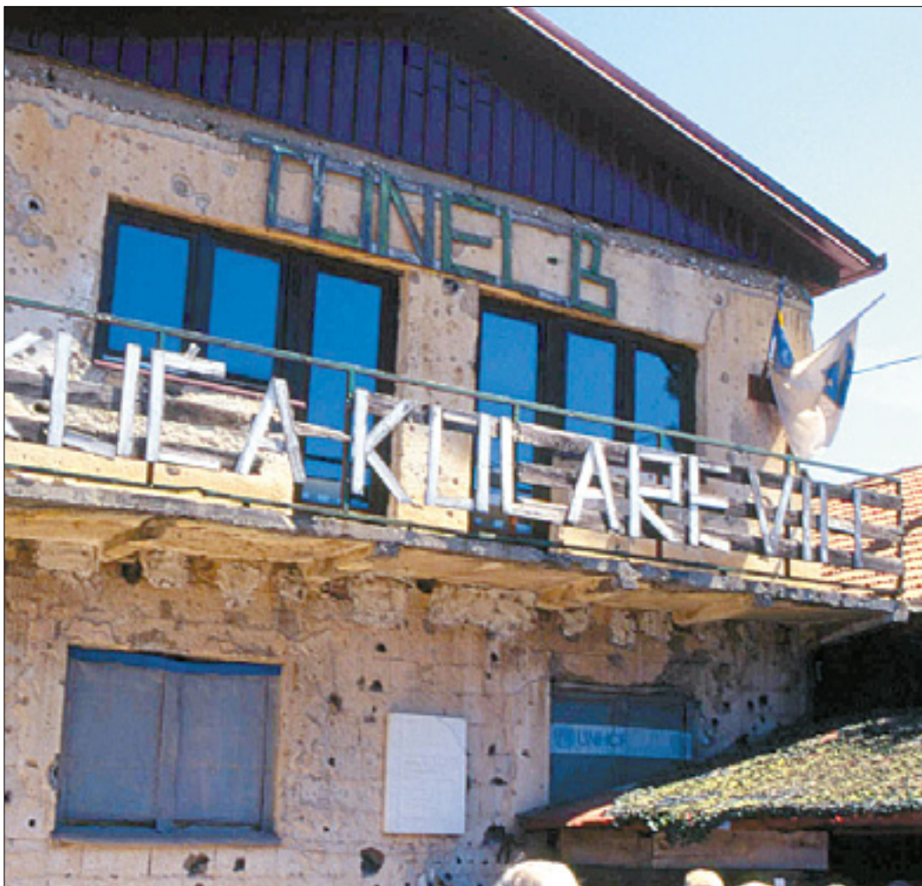
Hiša Kolare, kjer je bil vhod v tunel
