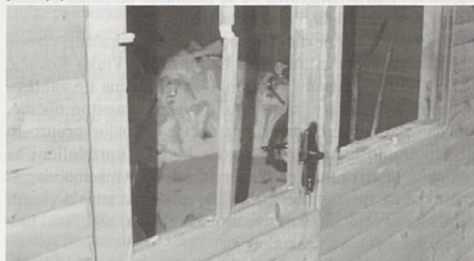
Detajl na vhodnih vratih, brez stekel, seveda
