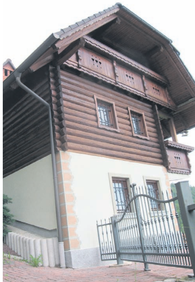
Ohranilo se je veliko starega stavbarstva. Tole staro hišo je obnovila družina z Gorenjske.
