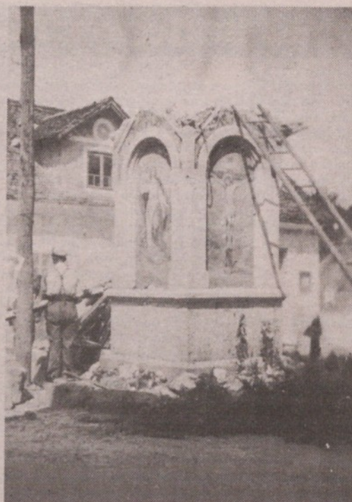
Rušenje, podiranje radomeljske kapelice Čudna moč krampov... (Foto: Ivo Kralj)
