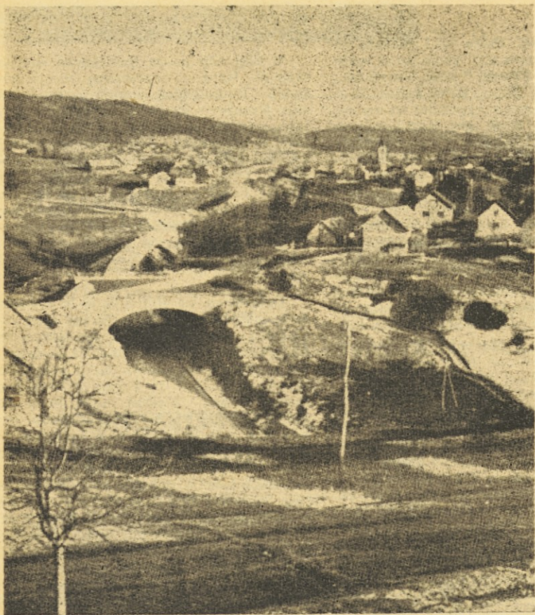
Nova avtomobilska cesta Ljubljana—Zagreb je pri Šmarju tako zgrajena, da so vsa križanja s krajevnimi cestami izpeljana v nadvozu
