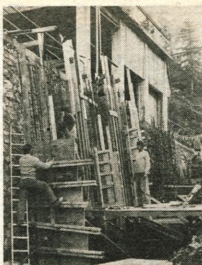
Nova zgornja postaja žičnice na Zelenici — Delavci splošnega gradbenega podjetja Tržič hite z granjo na Zelenici. Vremenske nepravilnosti in zob časa so namreč hudo načeli zgornjo postajo žičnice, zato so se žičničarji odločili zgraditi povsem novo, podprto z močnimi podpornimi stebri. Vreme gre graditeljem res na riko, vendar se zavedajo, da se zima bliža s hitrimi koraki, zato delajo vse sobote in vse nedelje.
