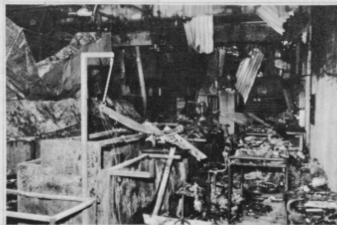
Za odpravo posledic požara bosta potrebna slaba dva meseca. Foto: Š. Hožyan
