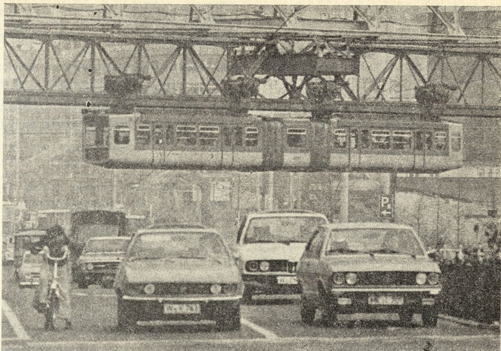
Stara železnica nad sodobno cesto
