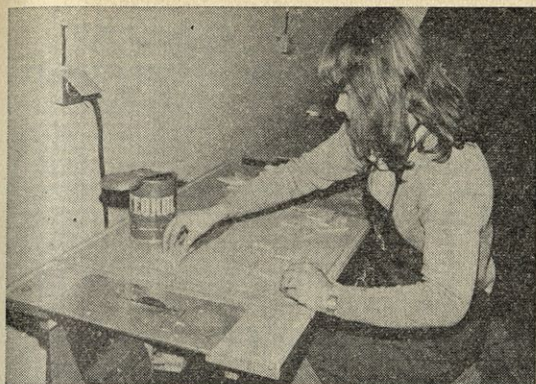
Slika 3. Lepljenje obrušenih ploščic na lesenitno podlogo. Za lepljenje uporabite neostik oziroma tekoč lepilo.
