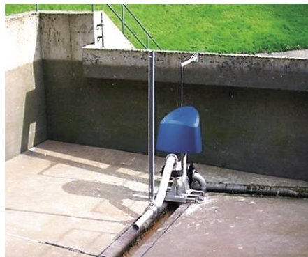
Slika 27 • Namestitev premičnega AWS-Strahljeta
