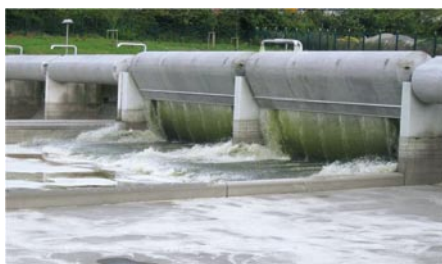
Slika 17 • Pogled na mirujoča splakovalna korita in dve delujoči
