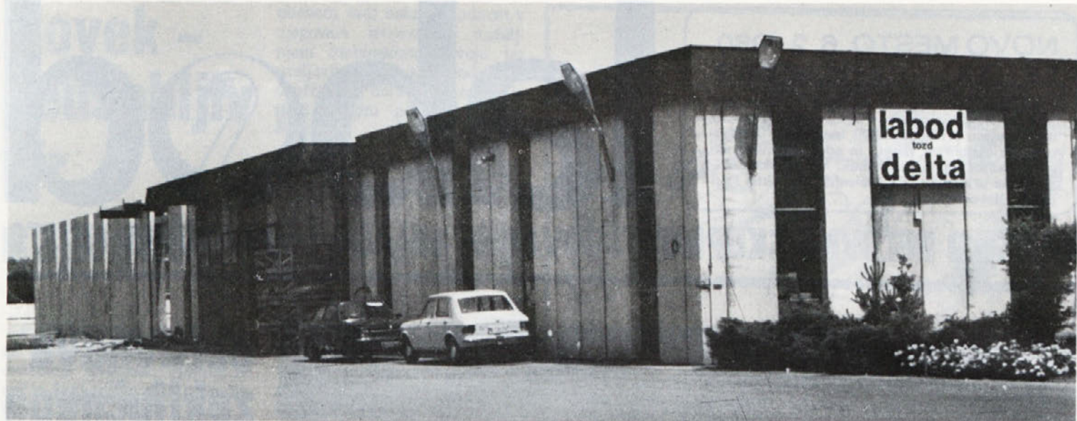
S končano industrijsko prodajalno je zaključena druga faza izgradnje
