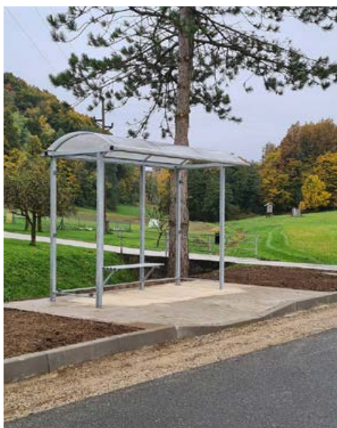
Urejena avtobusna nadstrešnica ob cesti na odseku Kornet v Pestikah
