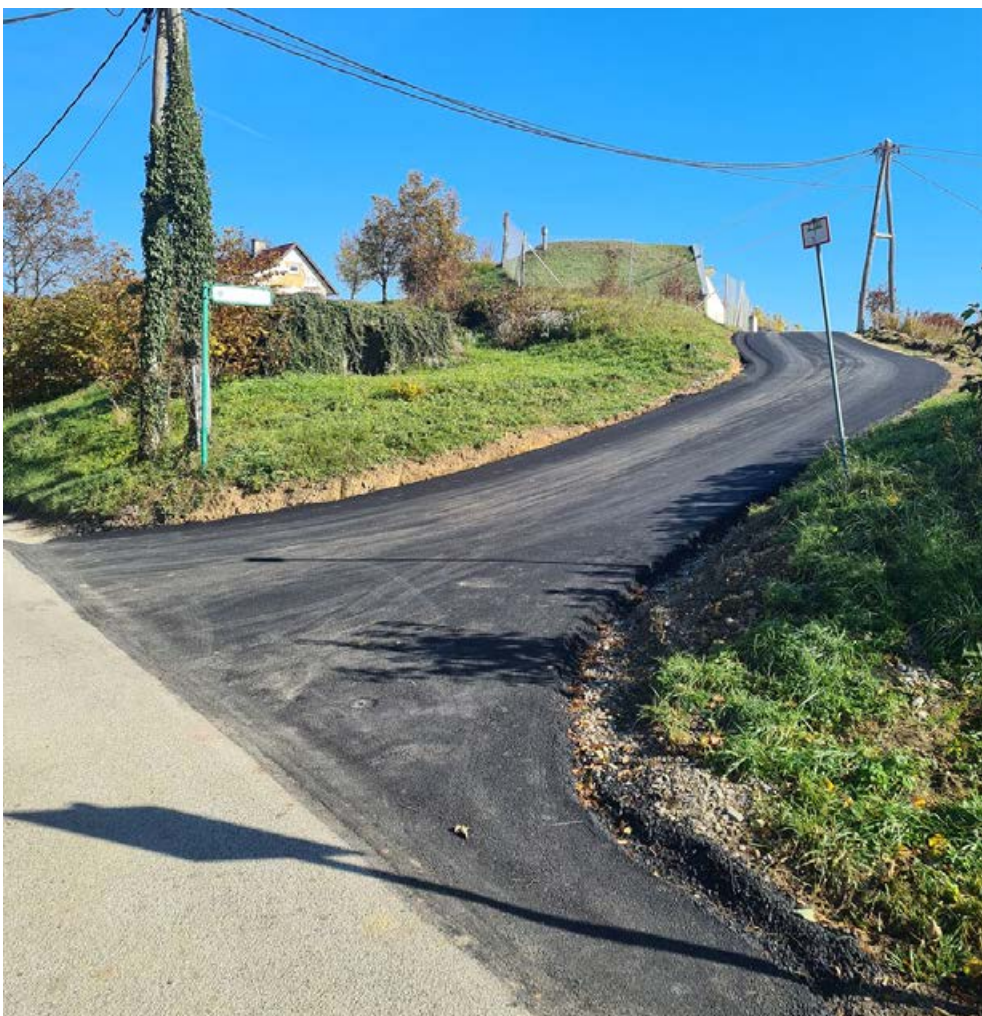
Posodobitev na odseku ceste Turški Vrh–Škrinjnar
