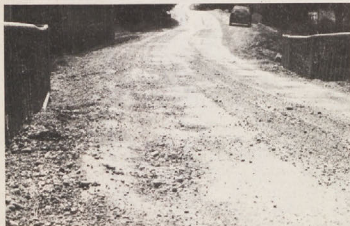
Cesta Vuhred - Ribnica
