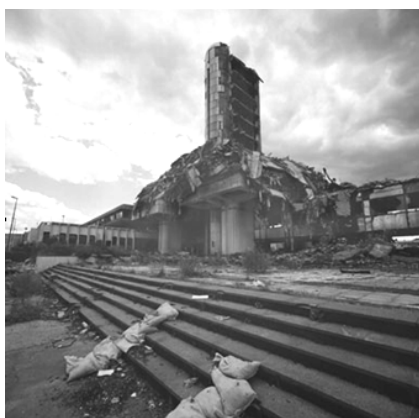
Poslovna zgradba bivšega časopisa Oslobođenje, današnji Avaz.
